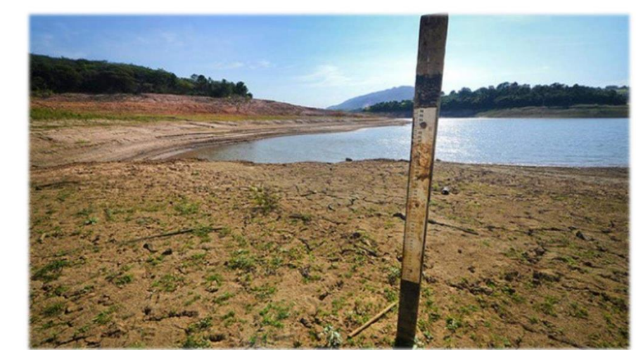
Reservatório localizado no Estado do Rio de Janeiro indicando baixo nível histórico no ano de 2015.
