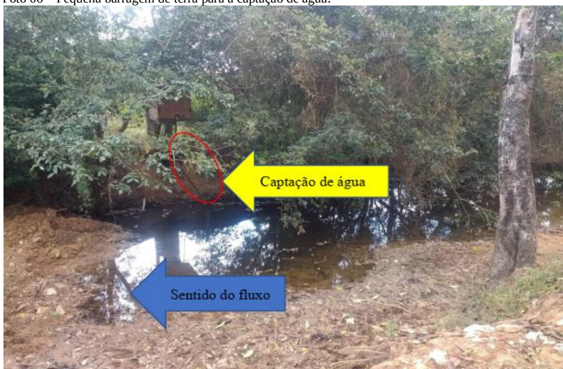
Foto 06 – Pequena barragem de terra para a captação de água.
